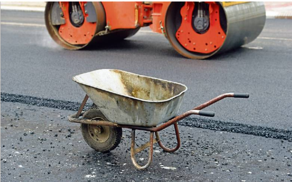
Vorsicht, Baustelle! Wenn Straßenbauer anrücken, wird es für Anlieger oft teuer. Nun stellt Niedersachsen CDU die Ausbaubeiträge infrage. Foto: dpa/Stefan Sauer
